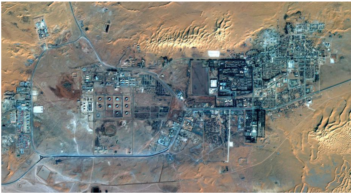
Figure 2 - centrale pétrolière et gazière d'In Amenas en algérie
